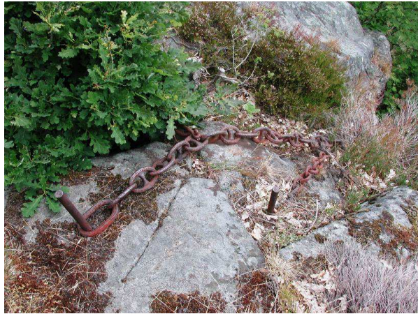
Figur 11: Sikring av avløste blokker med ankerkjetting, ved øvre ende av søkk som leder ned mot ytre ende av Havnegata
