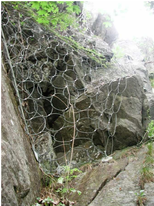
Figur 12: Litt lenger ned i samme søkk som i Figur 11. Øverst i høyre fotografi sikring av avløste blokker med ankerkjetting, i venstre fotografi med wirenett
