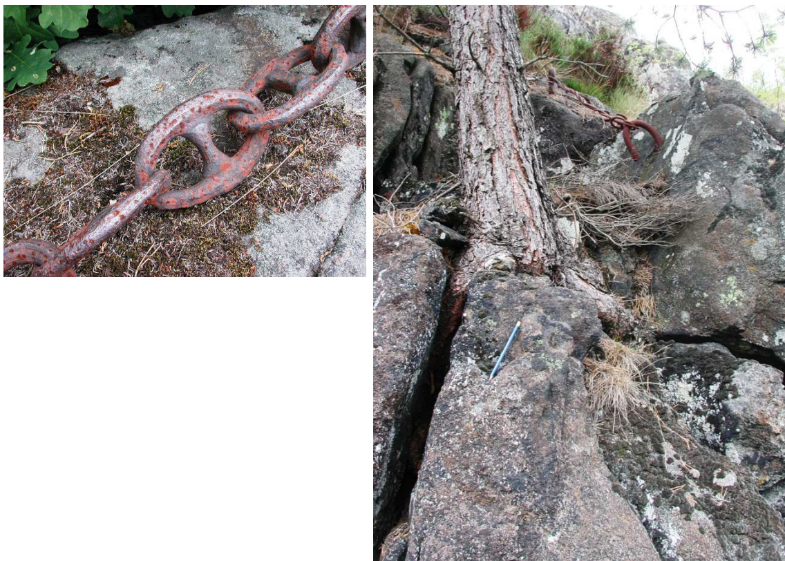
Figur 8: venstre : Bergsikring fra forgangne tider, med ankerkjetting
