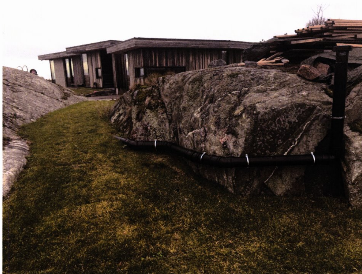
Bilde 6B: Viser området etter at lufterør er lagt i bakken og tildekket i etterkant. Man ser her tydelig røret som delvis er lagt i bakken og delvis i friluft for å sikre tilstrekkelig lufting til renseanlegget som ligger under hytta som sees i bakgrunnen.
