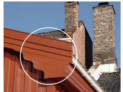
Ekstremt tilfelle pga. for kraftig gesimskasse
