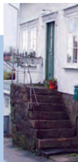
Smijernsrekkverk og natursteinstrapp
