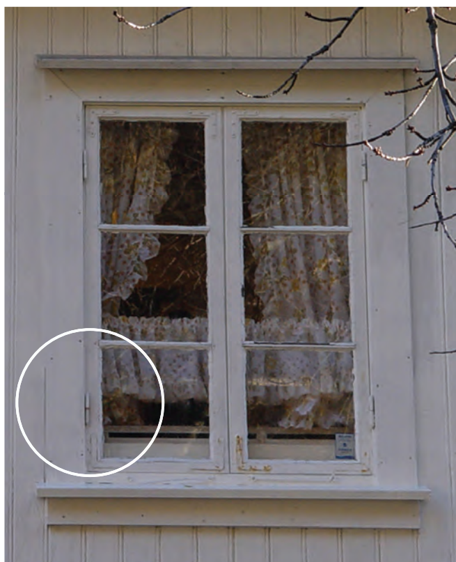
Foto viser et hus med originalvindu til venstre og utskiftet vindu til høyre på samme fasade. Utskiftet vindu er i isolerglass med feil dimensjon og detaljering på sprosser.
