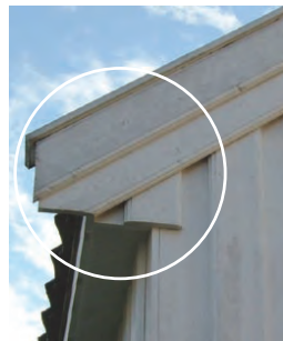
Noe uheldig detaljering i overgang vindski og gesims
