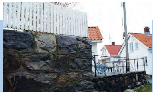
Foto viser eksempel på uheldig skiferforblending
