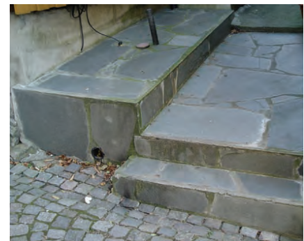
Foto viser eksempel på uheldig skiferforblending
