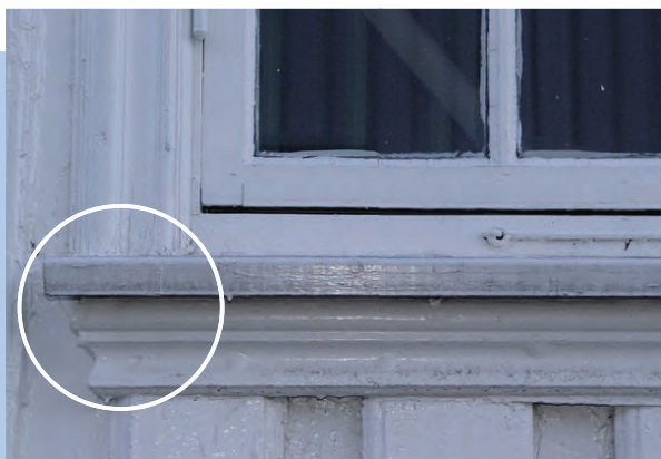
Reparasjon ved utskiftning
