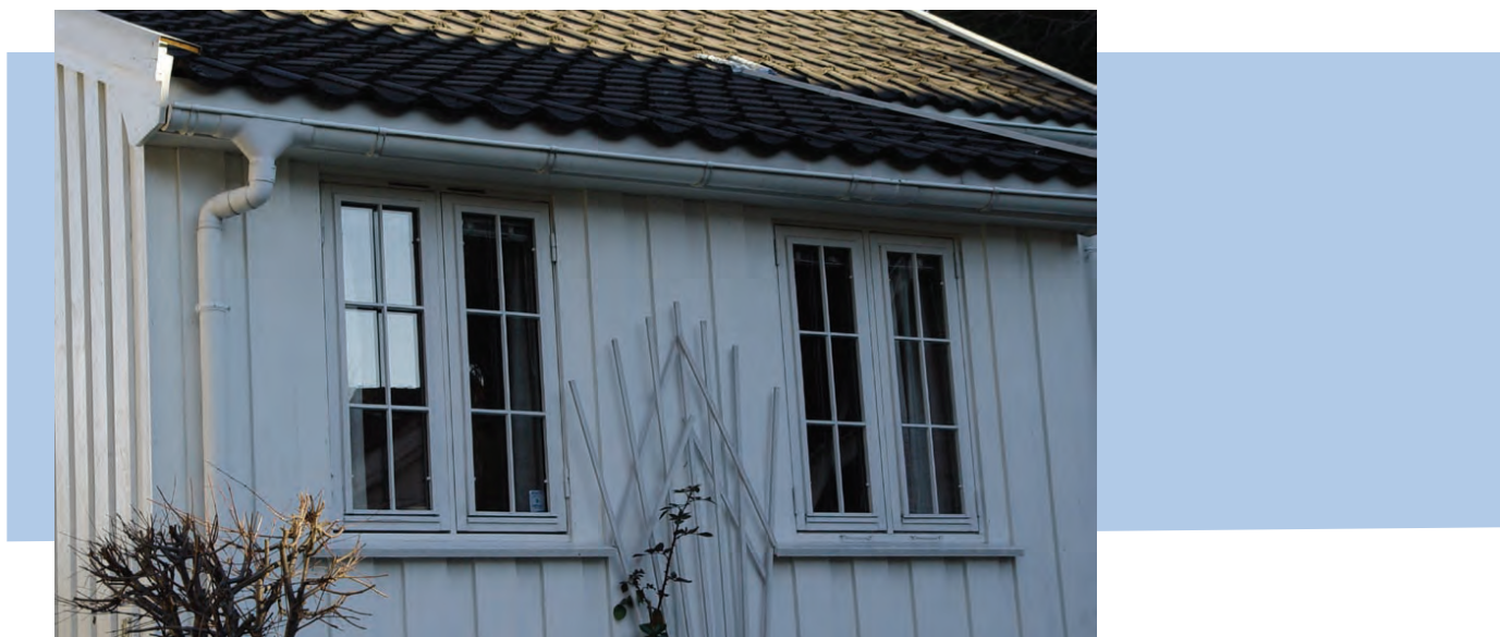
Foto viser lite heldig løsning med isolerglass og falske sprosser med feil sprosseinndeling.
