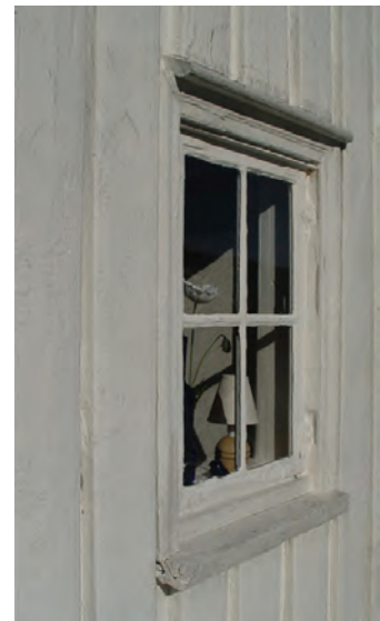
Originalt vindu med tilhørende panel og detaljering.
