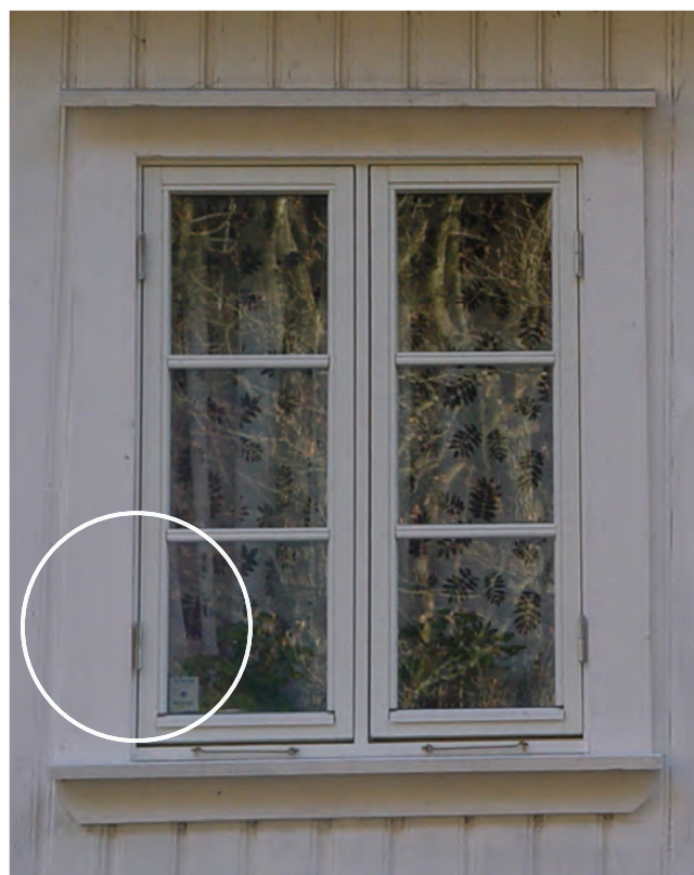
Foto viser et hus med originalvindu til venstre og utskiftet vindu til høyre på samme fasade. Utskiftet vindu er i isolerglass med feil dimensjon og detaljering på sprosser.
