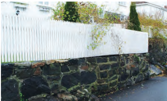
Stakittgjerde i forbindelse med natursteinsmur
