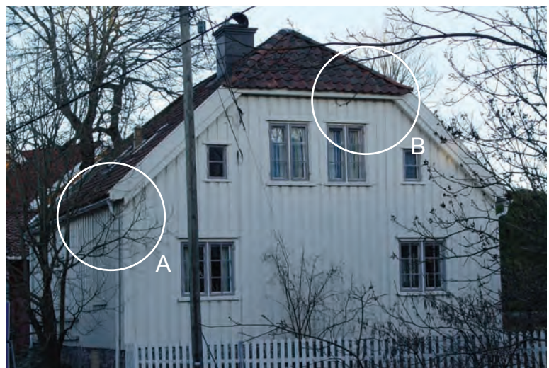
A riktig bruk av takrenne og nedløp B ingen takrenne på halvvalmen
