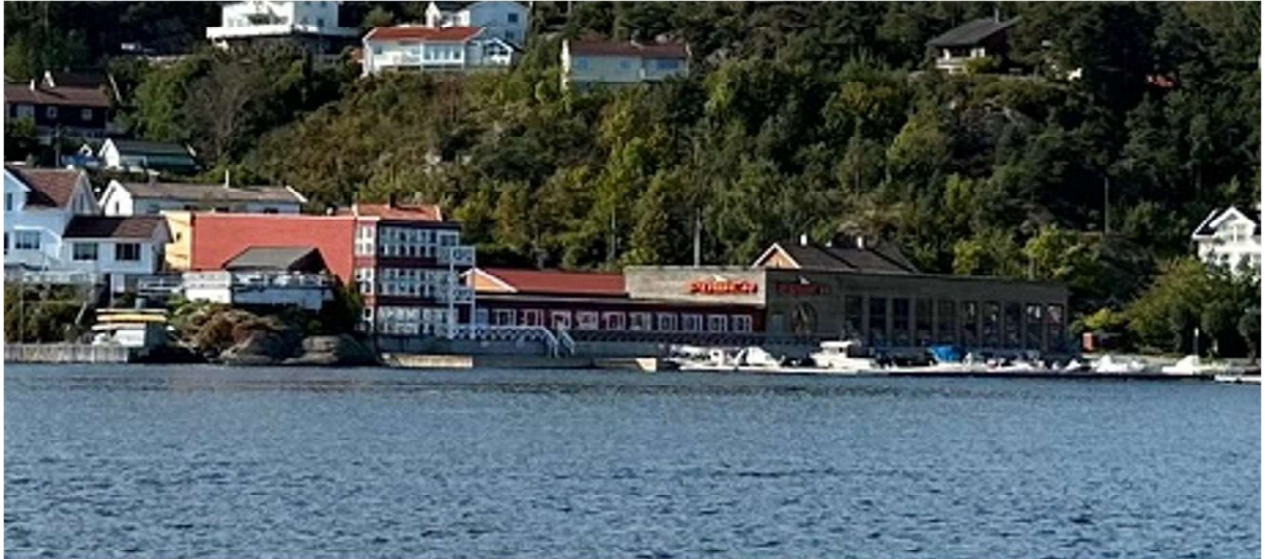
Buvikveien 21 sett fra sjøen, sommer 2024.
