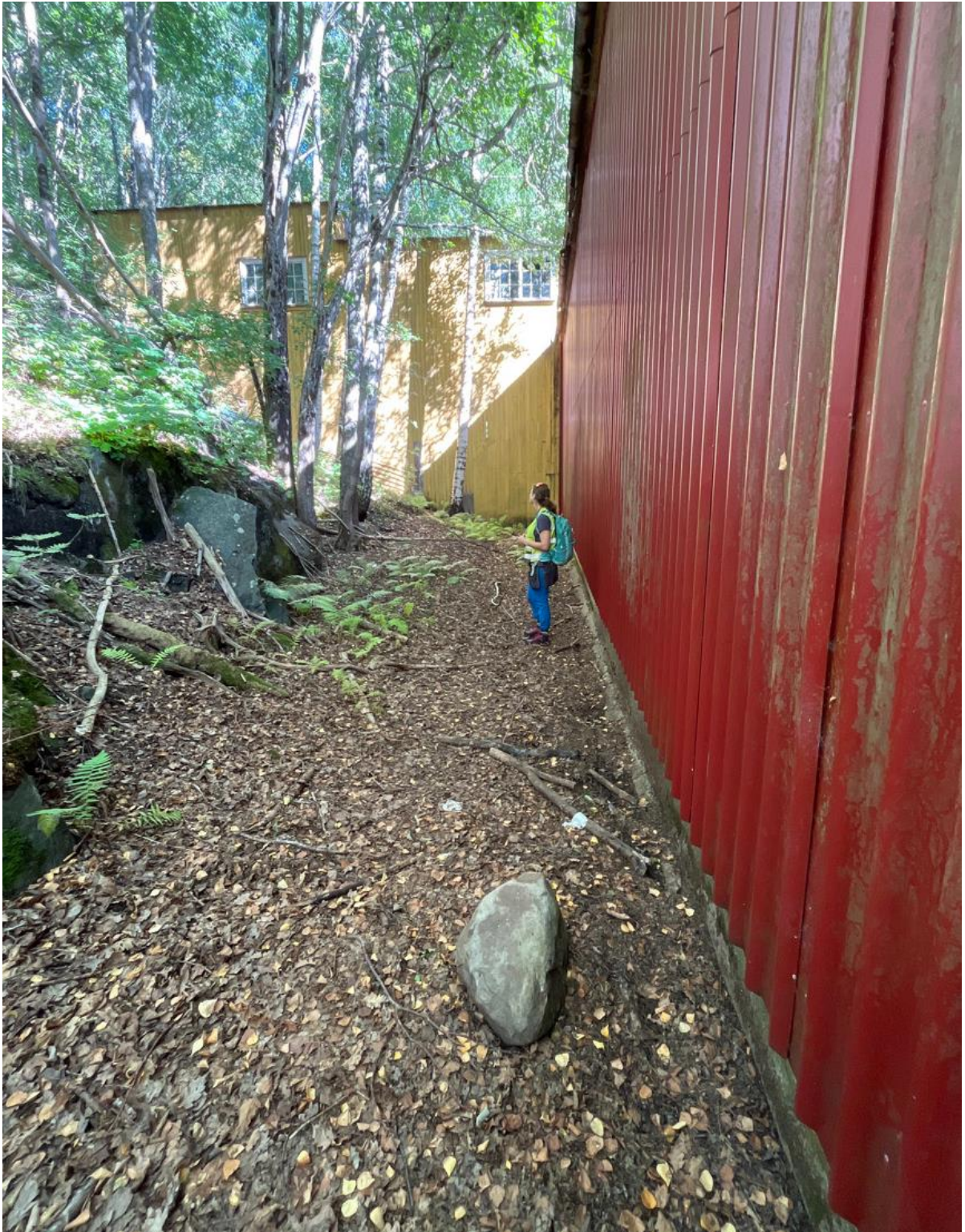
Figur 13: Bilde tatt mot øst fra punkt 3, på baksiden av eksisterende bebyggelse. Avrundet blokk ligger ved vegg. Denne vurderes å være avsetningsmateriale, ikke steinsprang, pga. avrundet form.
