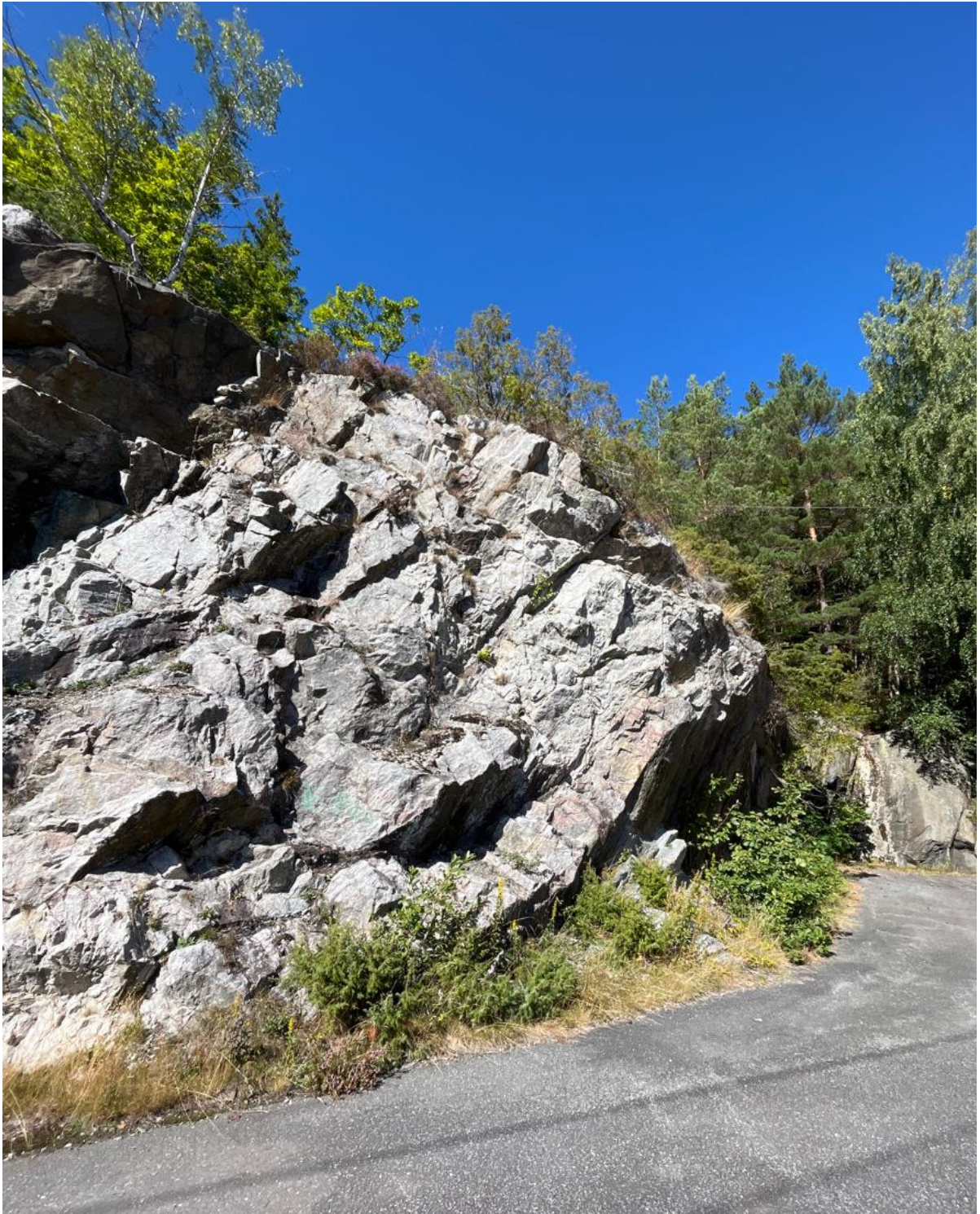
Figur 12: Bergskjæring 8 meter høy, bilde tatt ved punkt 2. Avløste blokker ble observert. Rotsprenging er aktivt i øvre del. Det er mulig med utfall ut i veien. Skjæringer inngår ikke som en del av skredfarevurdering iht. TEK 17, men på generelt grunnlag anbefales det at skjæringer vurderes av ingeniørgeolog i forbindelse med byggefase.
