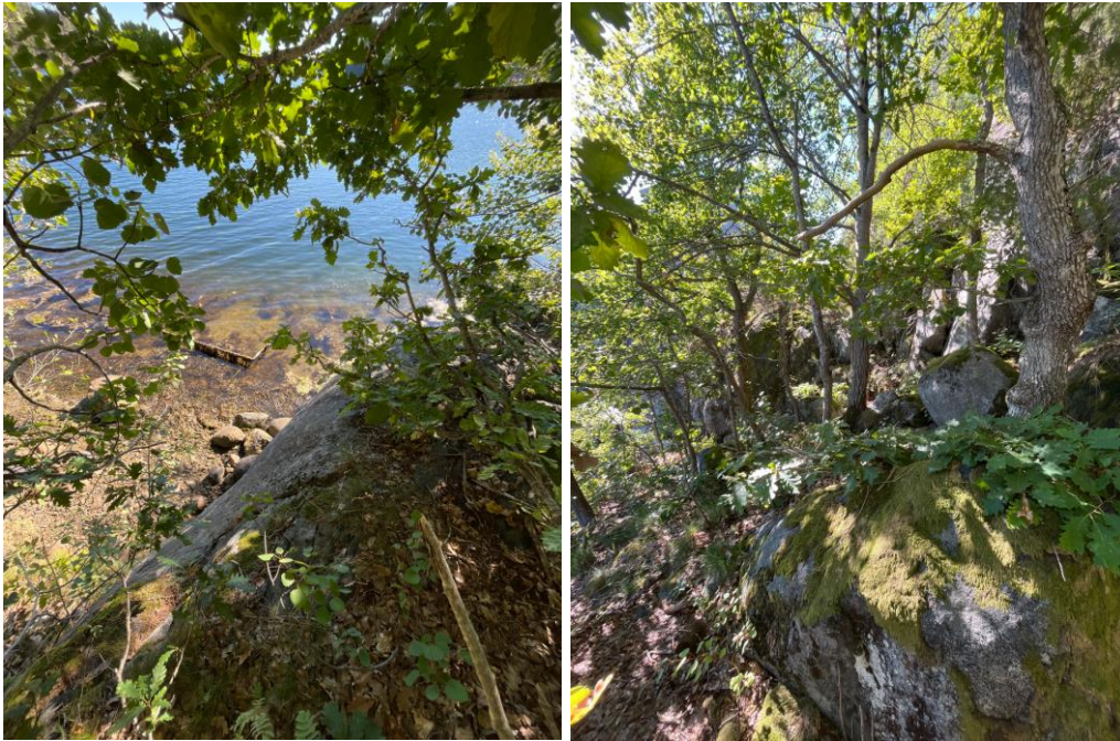
Figur 19: Klippeparti med svaberg, ned mot strand. Bilder tatt fra punkt 13, mot sør (venstre) og mot vest (høyre). Berget fremstår som kompetent, med stedvis avløste blokker. Det er kartlagt utfall opptil 0,5 m 3 på hyllene som bildene er tatt fra. Utfall herfra kan nå ca. 3 meter ut fra svaberget hvis de får sprett.
