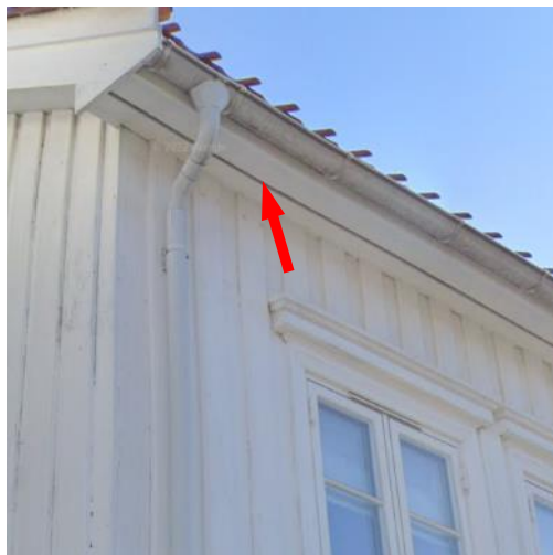
Figur 27: Eksempel på luftet takkasse.
