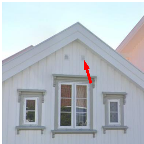
Figur 28: Eksempel på ventil i møne.
