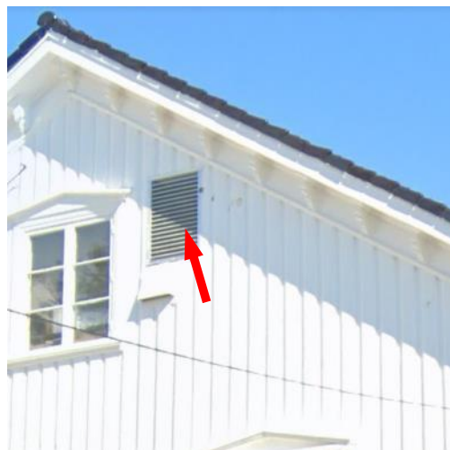
Figur 30: Større ventil i gavlvegg.
