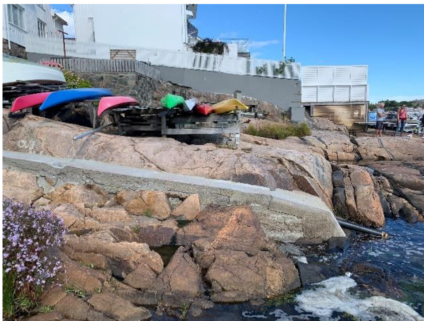
Bilde 12. Kajakkopplag og avløpsledning med betongdekke, område 5 og 9
