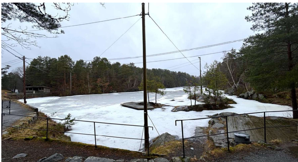
Figur 4: Demningen sør i Barbuliabassenget. Bildet tatt mot nord.
