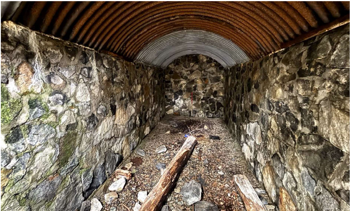
Figur 13: En av bunkerne (ID 328954-13) med buet tak med betong og steindekke.
