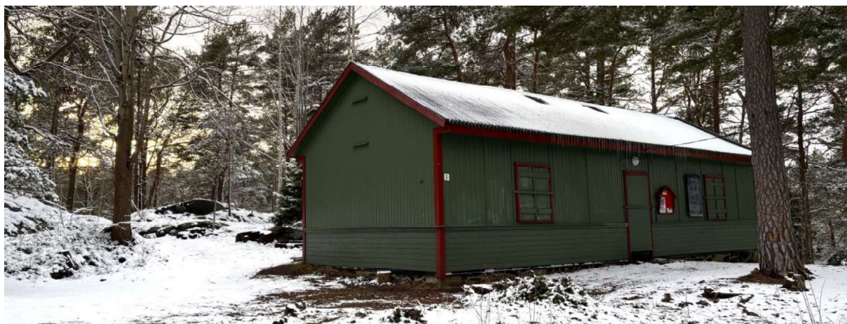
Figur 9: Den gjenværende brakka (ID 328954-57). Brakka disponeres i dag av Risør Barneskole. Bildet tatt mot vest.
