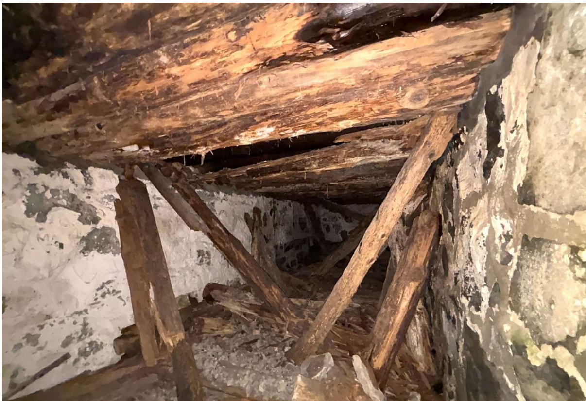
Figur 14: Bunker med furustokker fortsatt delvis bevart i taket.
