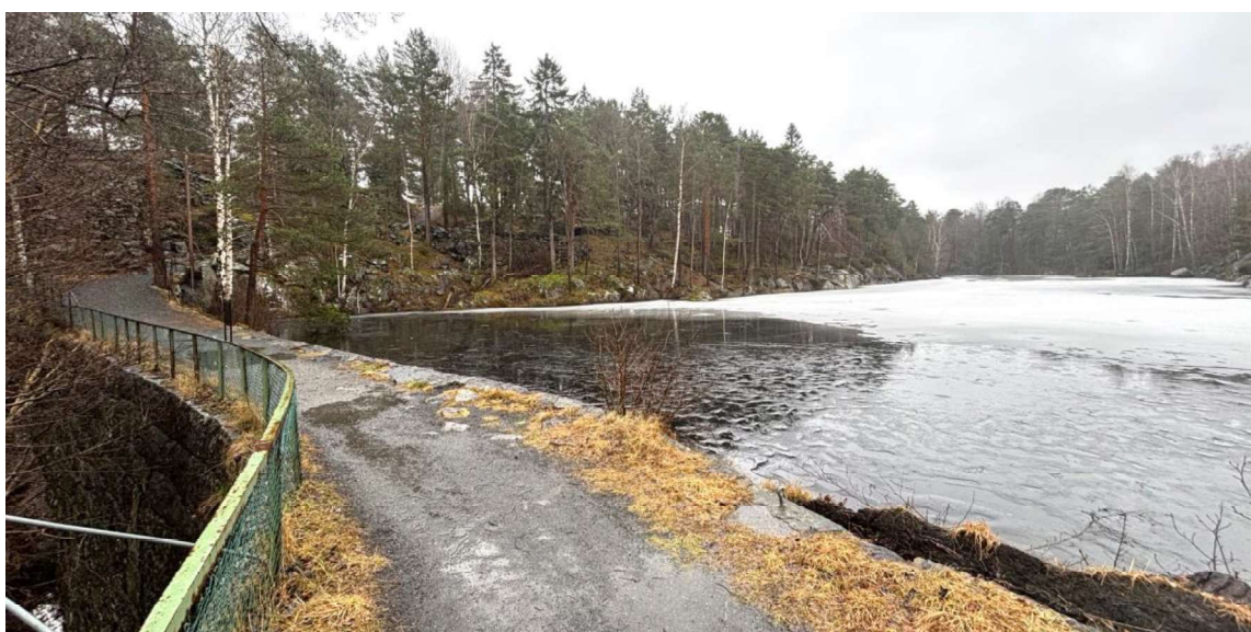
Figur 3: Demningen nord i Urabassenget. Bildet tatt mot sør.
