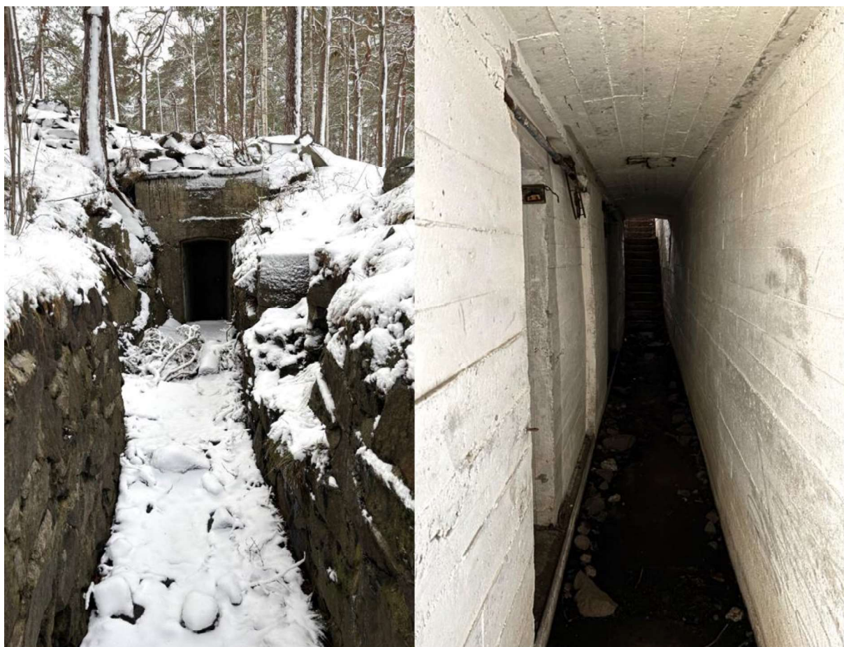
Figur 19: Til venstre: løpegrav som fortsetter under bakken. Til høyre: løpegrav under bakken med inngangen til to ammunisjonsbunkere (ID 328954-20) til venstre i bildet.
