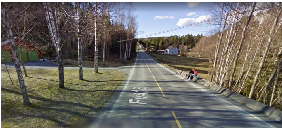
Figur 13: Fv 416 Aklandsveien nord for Torbjørnsdalen, vei med midtstripe, Google Streetview
