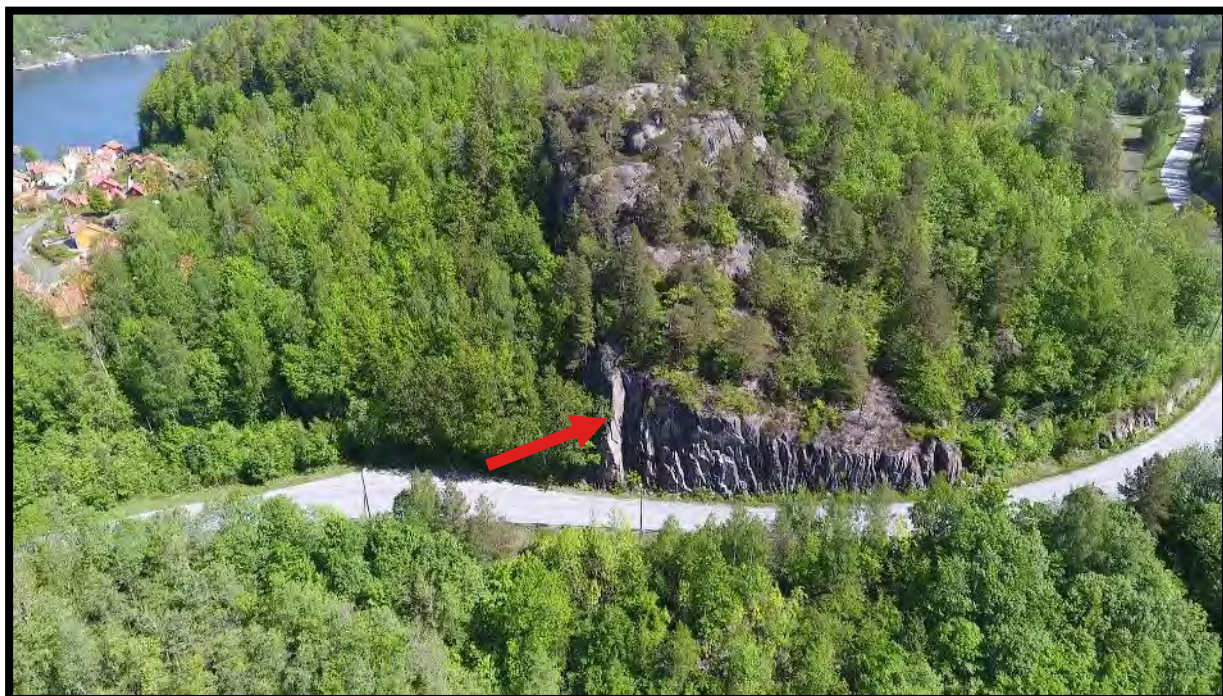
Figur 37. Oversiktskart bergskjæring ved Sauvika. Nedfall 2007 markert med rød pil.
