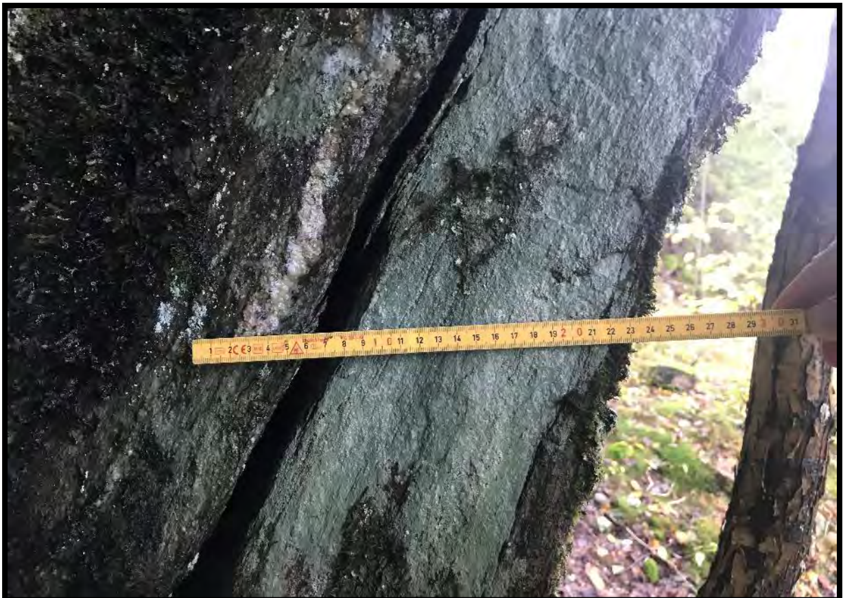
Figur 42. Oppsprekning langs foliasjon. Sprekkeavstand noe tettere i dagfjellet.
