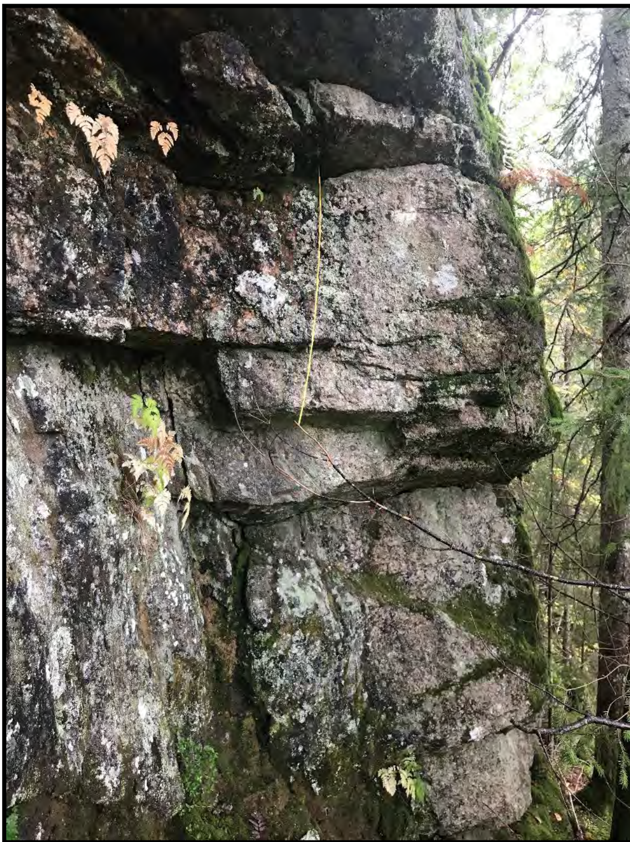
Figur 24. Tydelig benkning i bergmassen. Meterstokk midt i bildet.
