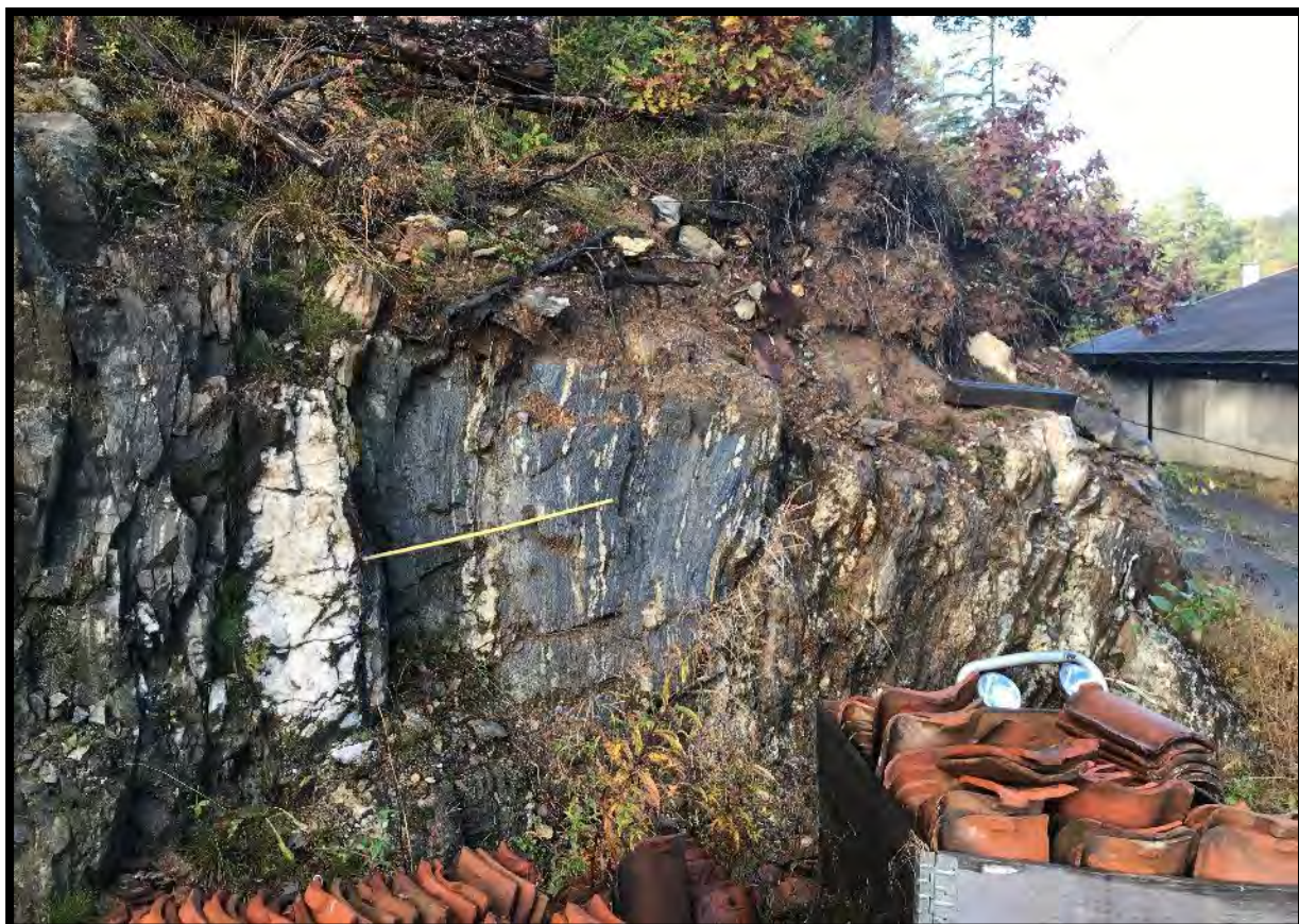
Figur 45. Bergmasse bak Risør trapp (legg merke til meterstokk). Senterlinjen er omtrent midt i bildet.
