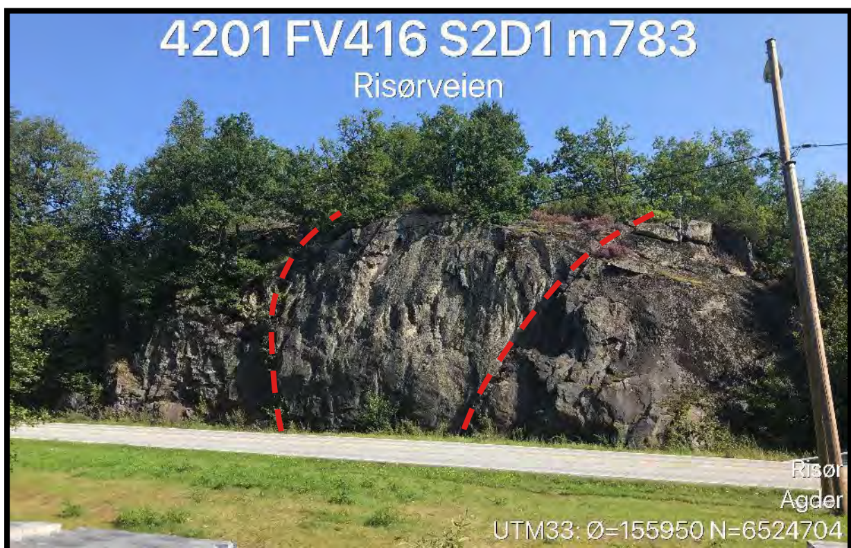
Figur 32. Bergskjæringen ved Røed. Mer oppsprukket i nordre del.
