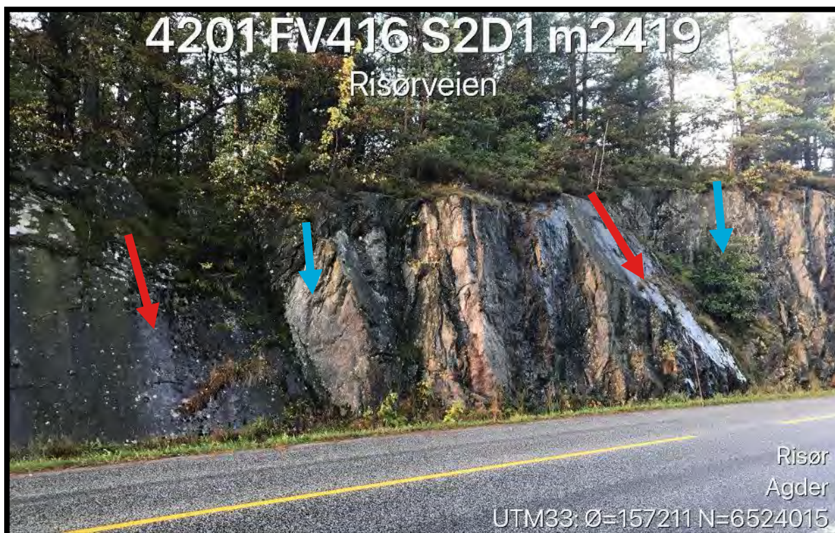
Figur 49. Eksisterende skjæring sett mot V. Piler indikerer sett 2 (blå) og 3 (rød).
