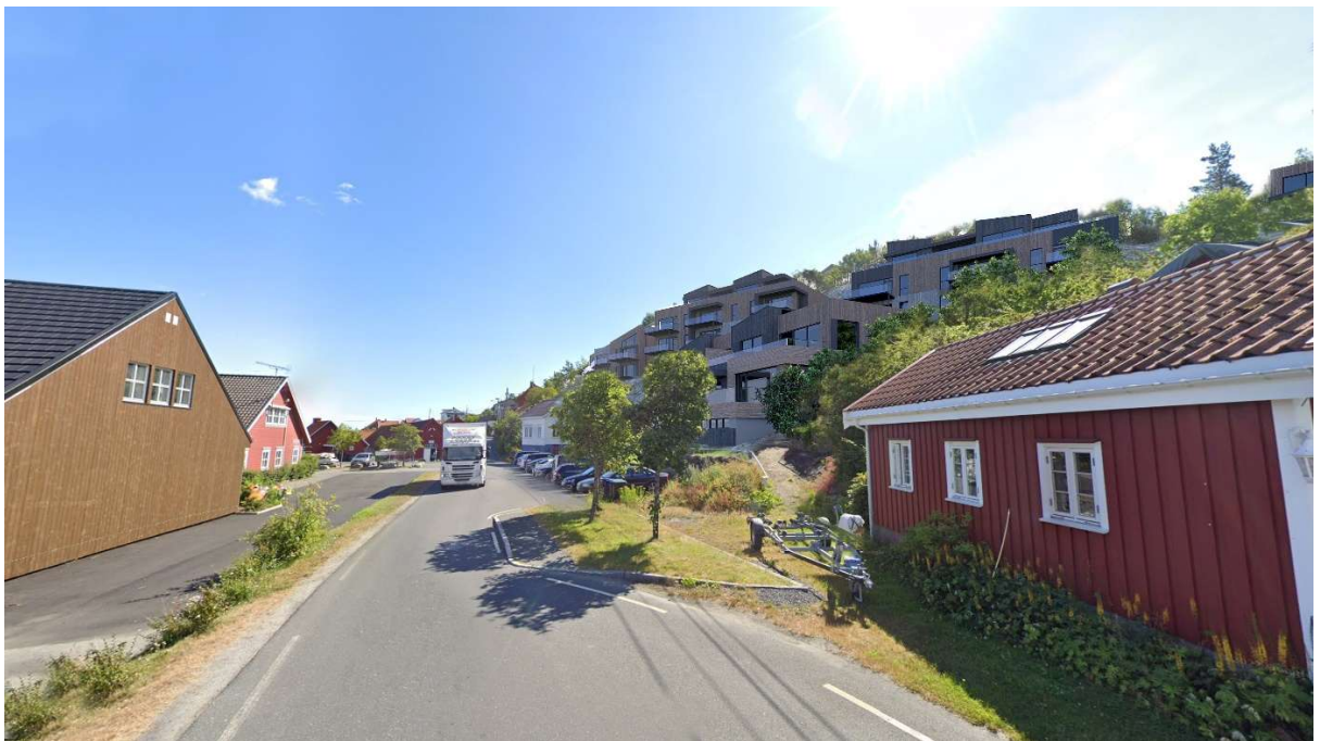
Figur 18: Prosjektet sett fra nordvest i Kranveien
