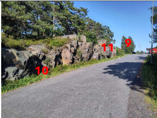
Bergskjæring som viser plassering av prøvepunkt 9-11. Skjæringen framstår som reeltivt massiv gneis (9-10)/amfibolitt (11), men mange rustne bruddflater. Stedvis bånd med mer dyptgpende rust (11)
