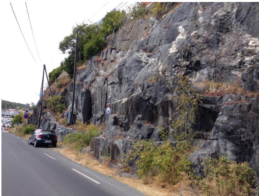
Bilde 4. Eksisterende veiskjæring langs tomt.
