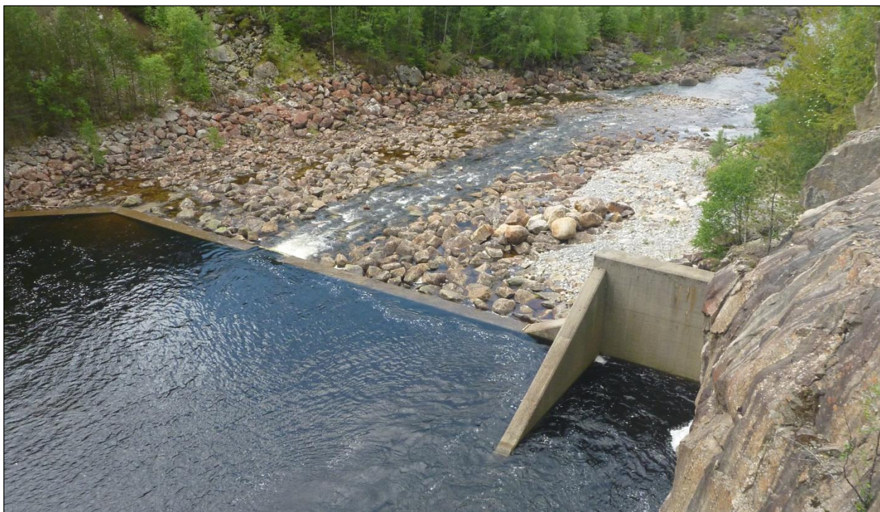
Smelandsdammen, foto: Stig Skjævesland
