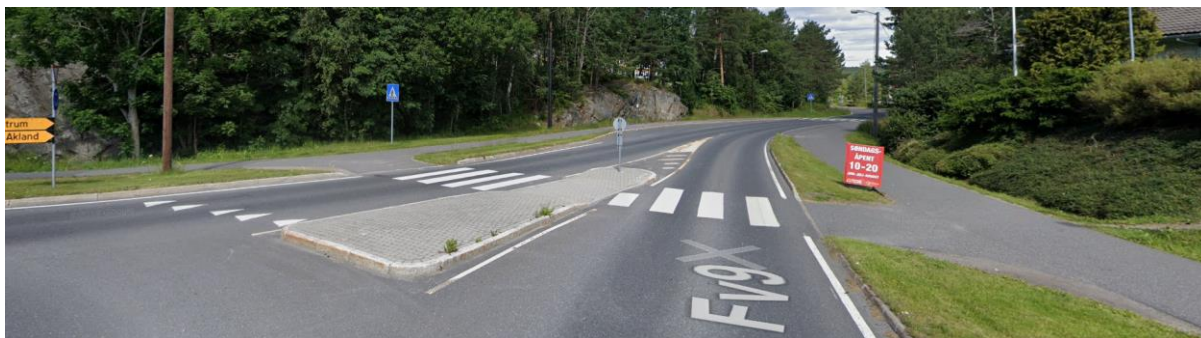
Figur 9 Fortau med kryssing i plan ved rundkjøring like ved skoleområdet.
