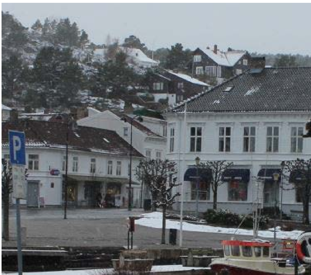
Torvet 3, godt eksempel på brukket hjørne og valmet tak.
