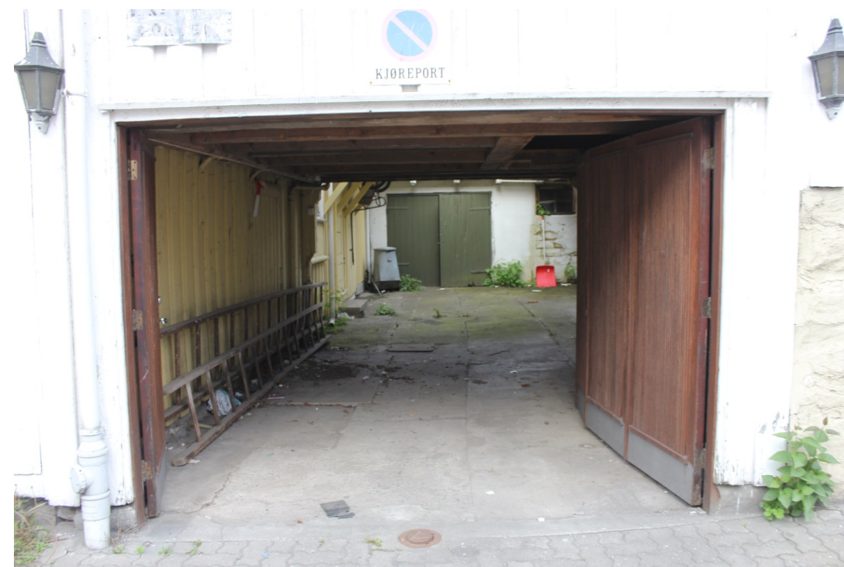
Inngang til garasjen Havnegaten 8, fra Storgata.
