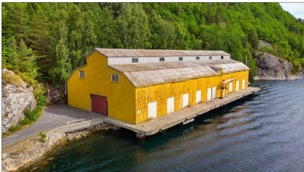
Figur 3 – Nedlagt utskipningshall for tremasse som skal rives og erstattes med fritidsbebyggelse.
