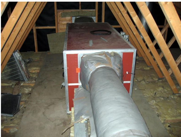
Figur 8 Ventilasjonsaggregat
