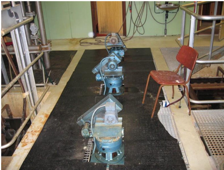
Figur 14 Flokkuleringsomrørere
