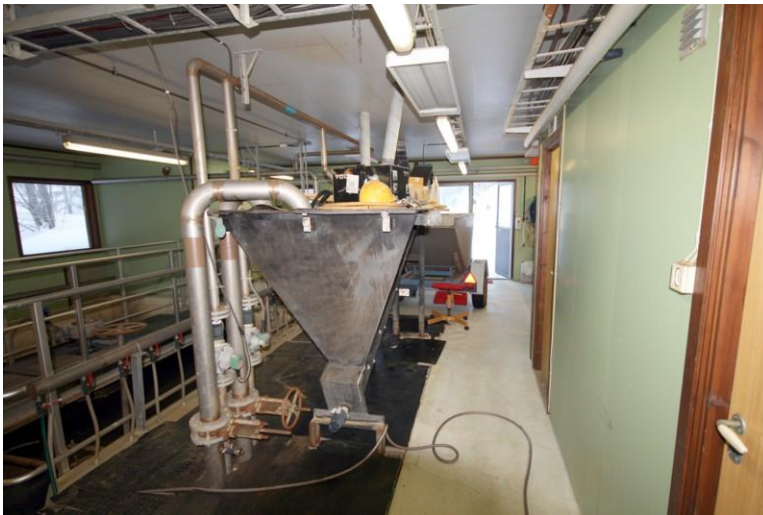
Figur 12 Sandavvanner og mamutpumper
