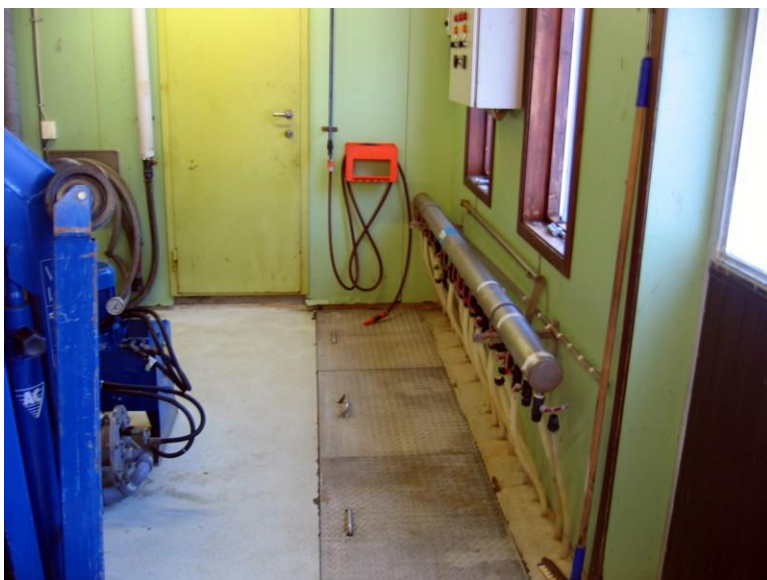
Figur 16 Manifold og lufterør
