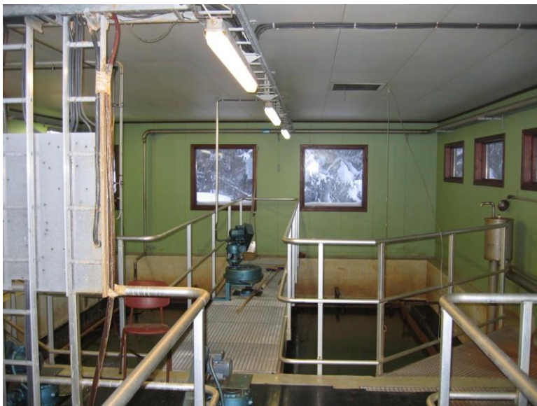
Figur 13 Rundslamskrape ettersedimentering
