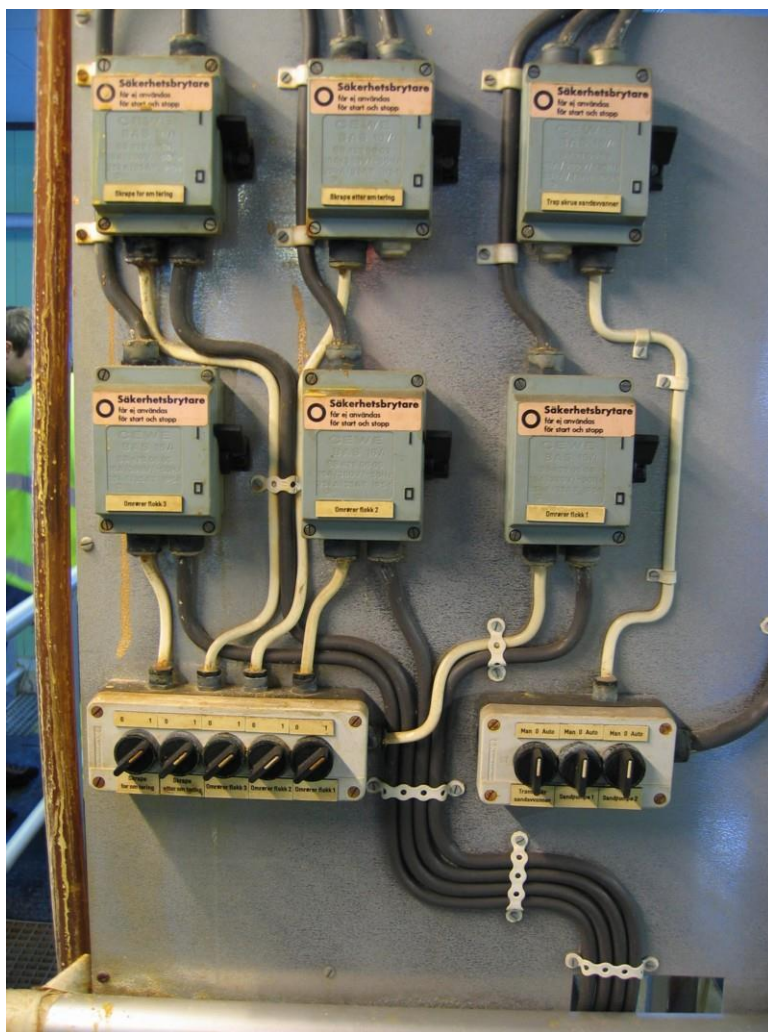
Figur 21 Sikkerhetsbrytere og vendere for lokal styring
