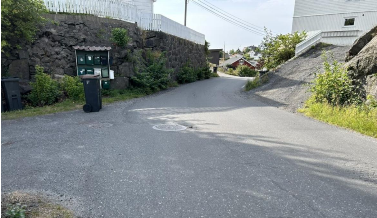
Figur 6 Buvikveien har stedvis smal veibredde og kort siktlengde. Foto SHG aug. 2025
