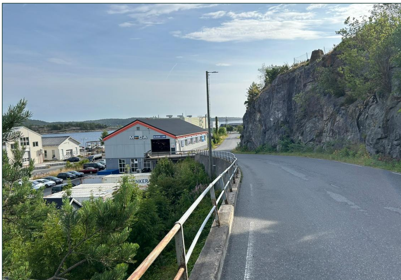
Figur 1 Fv. 3452, Kranveien. Foto Asplan Viak, SHG, august 2025
