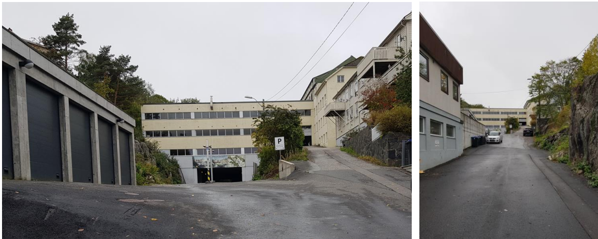
Figur 8. Livbeltefabrikken slik en ser den fra Hasdalgata.
