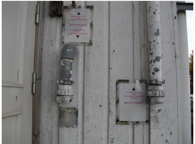
Figur 7 Påkobling for sprinkleranlegg fasadesprinkleranlegg
