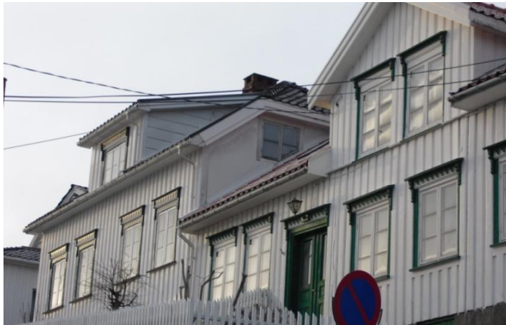
Figur 5 Kort avstand og vindu i gavlvegger
