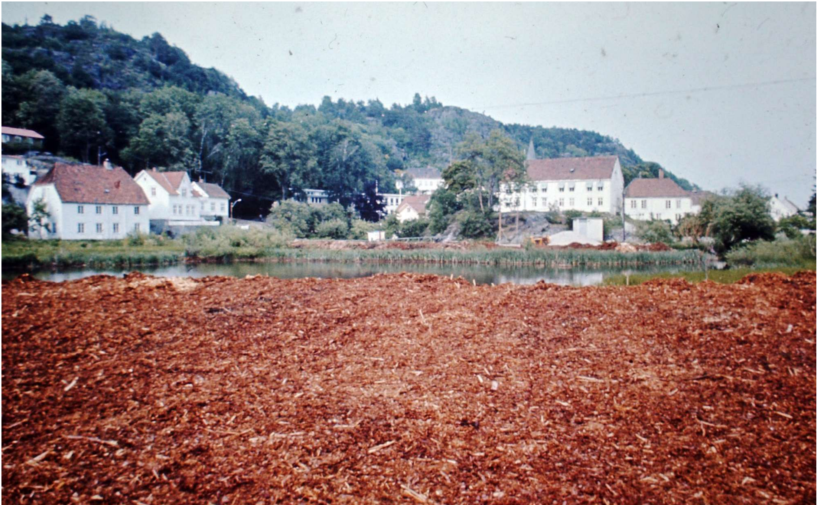
Foto tatt under oppfylling av Tjenna med bark, Foto Kjell Skarheim.
