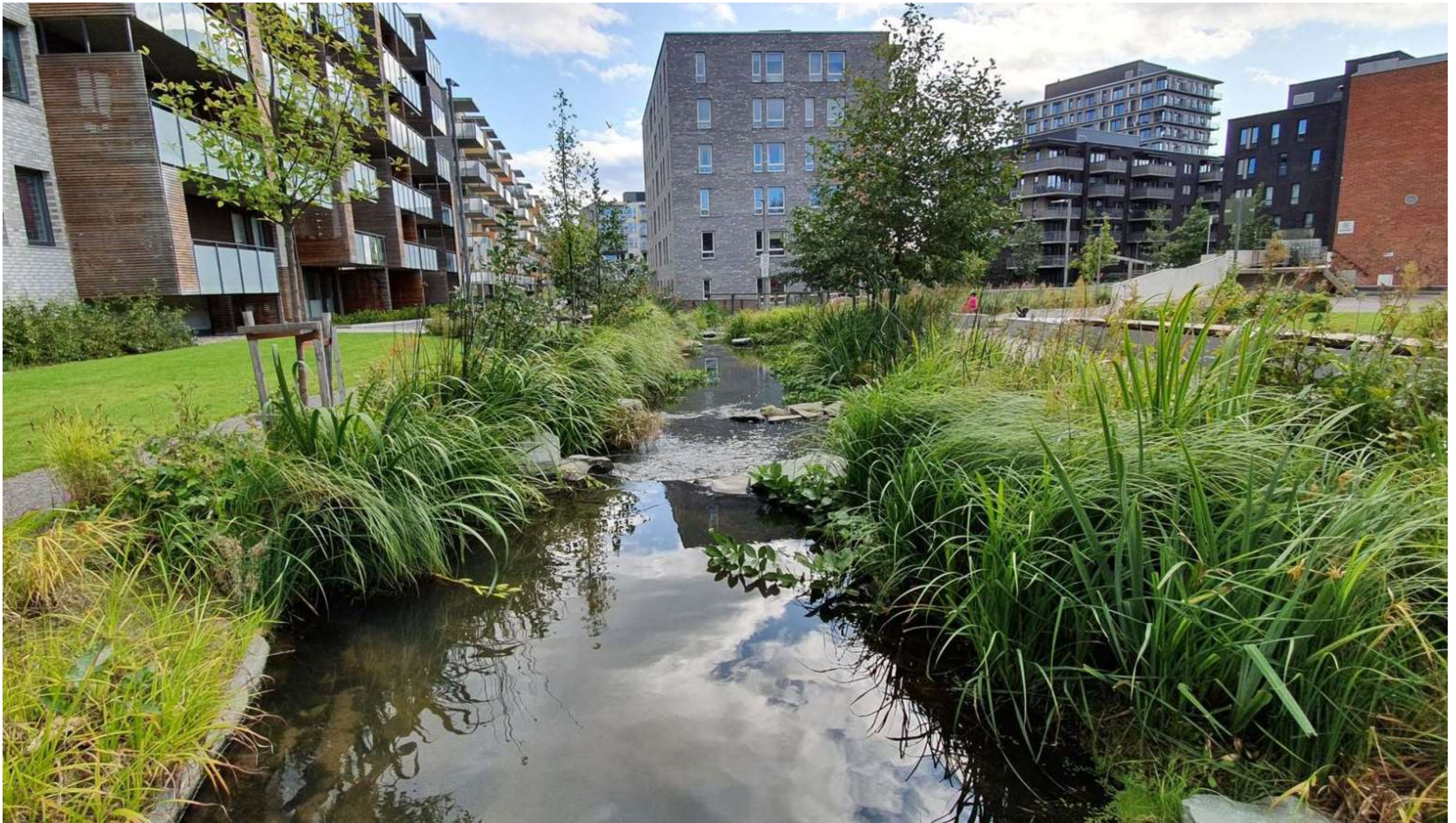
Ensjøparken - Ark. Bjørbekk og Lindheim - åpen overvannshåndtering gir visuelle kvaliteter og flomsikring.
